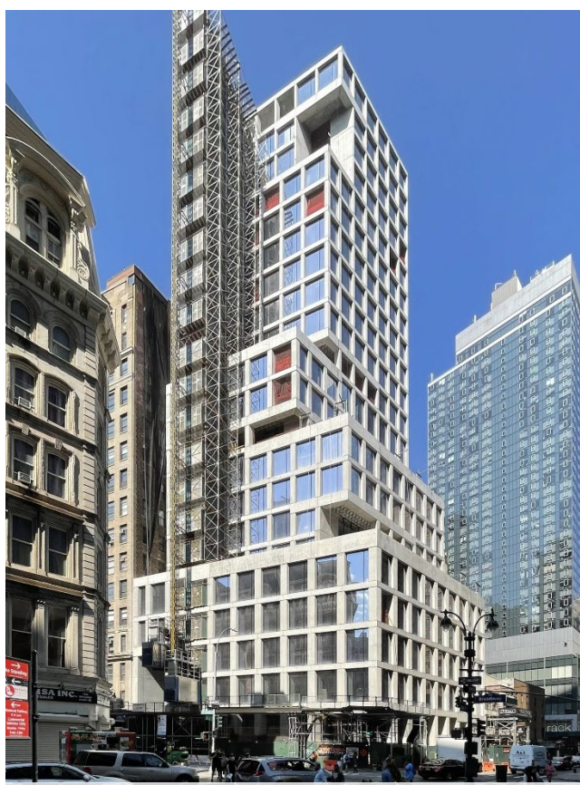
1245 Broadway, New York. Pågående projekt, beräknas färdigställas under fjärde kvartalet 2022.
