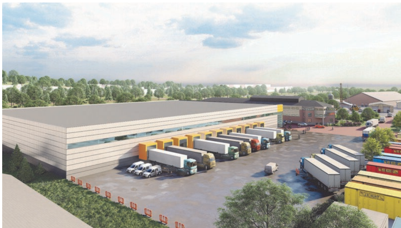
Planerad miljöcertifierad nyproduktion i Göteborg. På Exportgatan 30 i Hisings Backa planerar Corem att uppföra cirka 9 000 kvm ytor för lager och logistik med citynära logistikläge. Lokalerna kommer att anpassas efter de hyresgäster som tecknar avtal.
