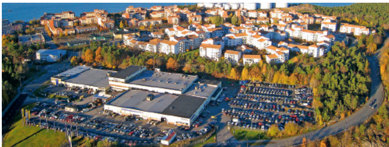
Sicklaön 356:1, Jarlabergsvägen 2, Nacka
